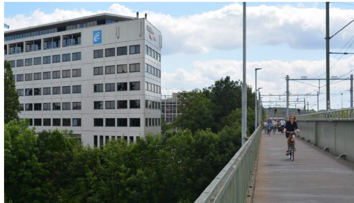
Huidig beeld fietsverbinding via de spoorbrug
