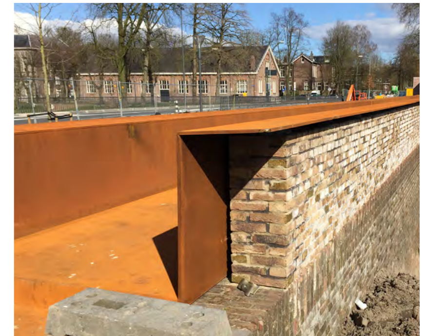
Vestingwand opgraven en zichtbaar maken
