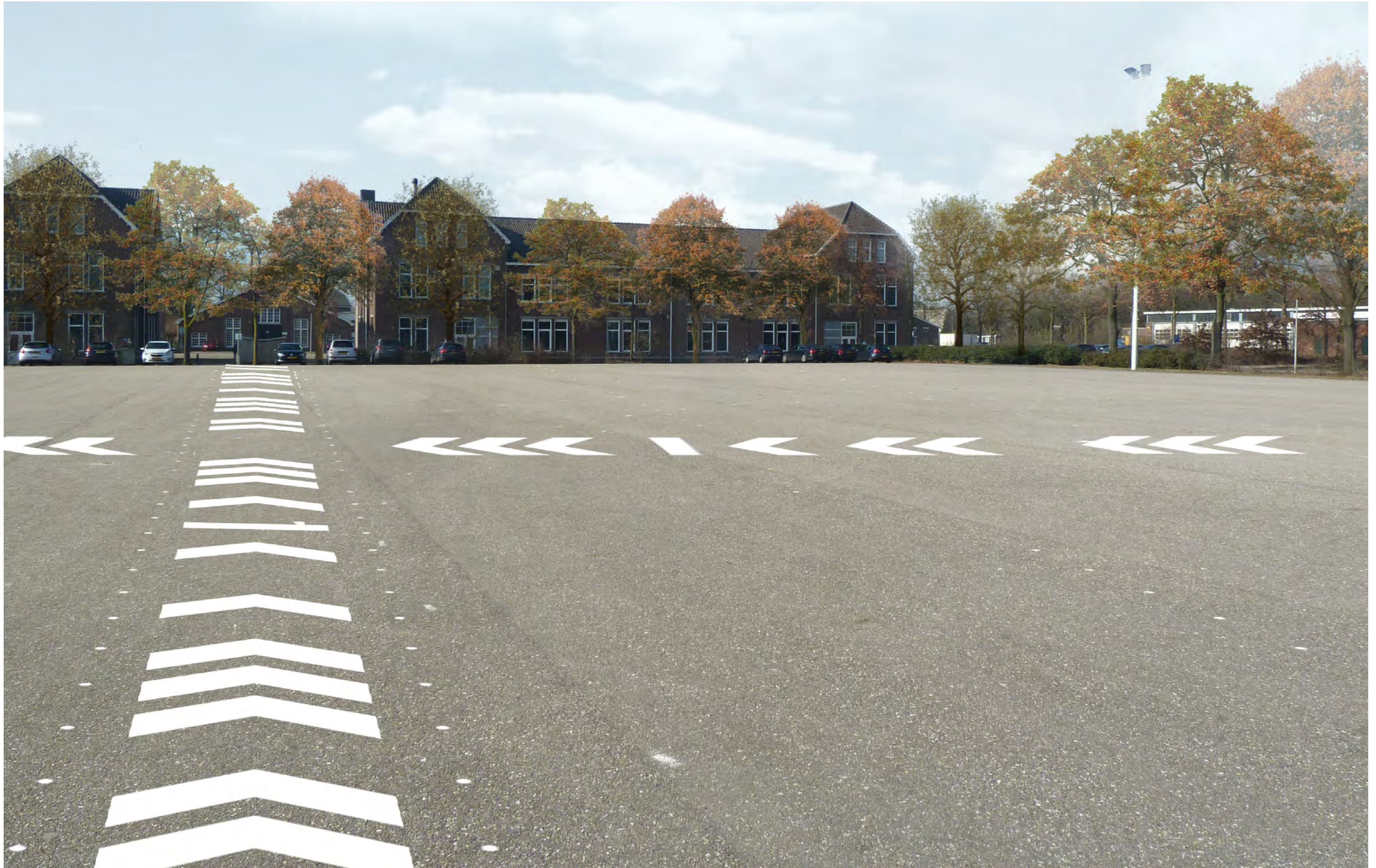
parkeerplaats met route markering en markering parkeerplaatsen
