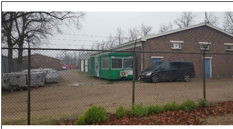
Foto 14: Gebouw X en Y
