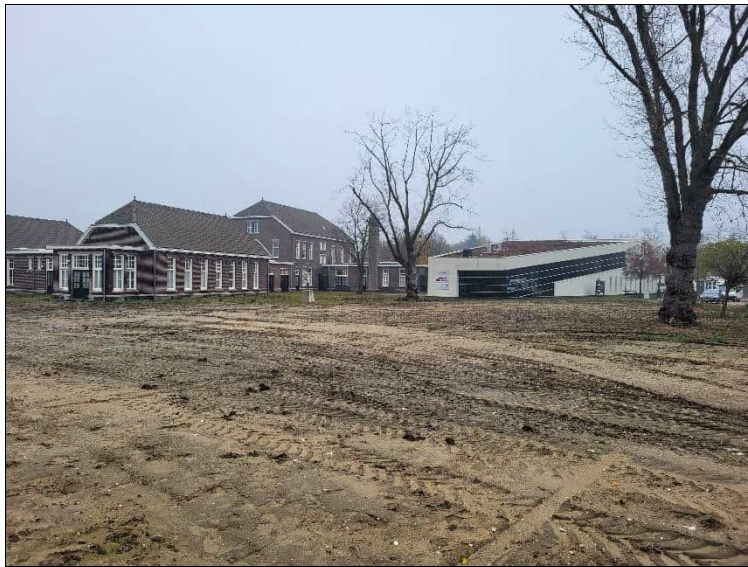
Foto 1: Topcare gebouw gezien vanuit het zuiden
