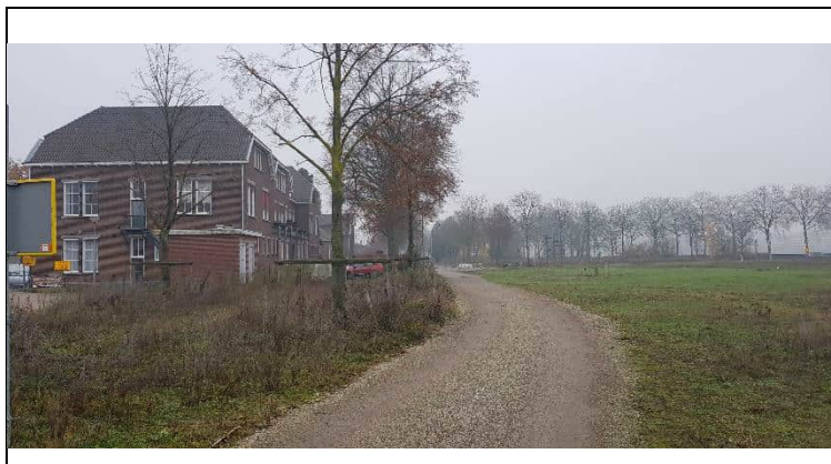
Foto 6: Weg voor gebouw A
