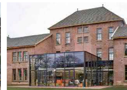
Tapijnkazerne Maastricht voor en na restauratie
