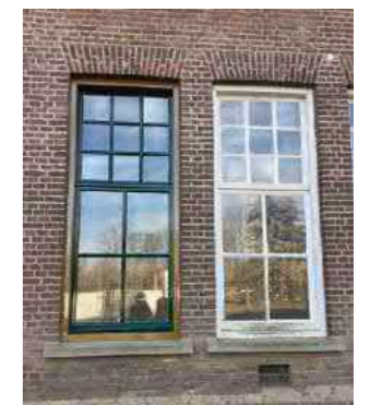
restauratie bestaande houten kozijnen Tapijnkazerne
