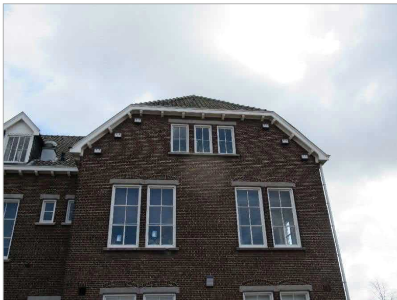
Figuur 6.3. Aangeboden huismuskasten in de nabijheid van de oorspronkelijke locaties.
