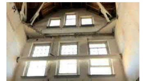
na verwijdering verlaagde plafond Tapijnkazerne
