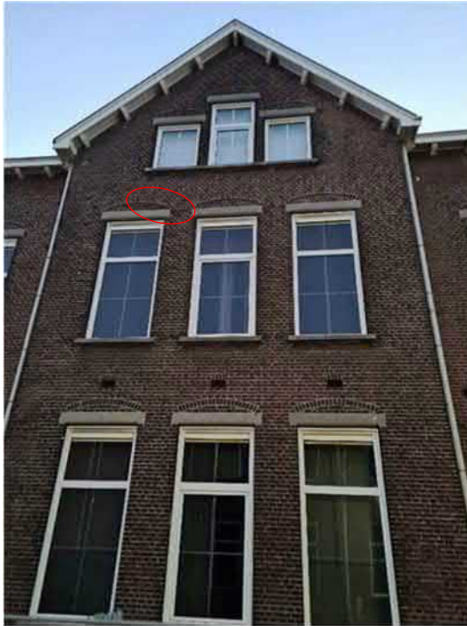
Figuur 4.7. Lb: zomerverblijf gd gebouw S, Rb: zomerverblijf gd gebouw B, Lm: zomerverblijf gd gebouw E, Rm: zomerverblijf gd gebouw A, Lo: zomerverblijf gd gebouw F.
