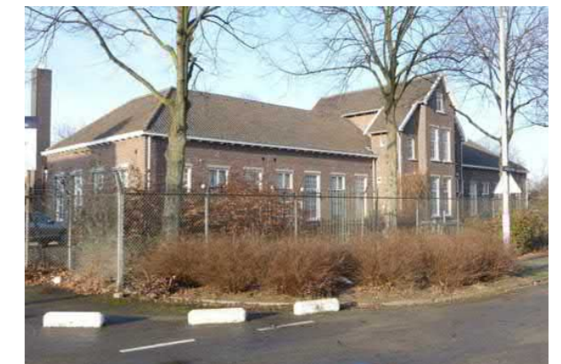
huidige staat voormalige kantine I, Frederik Hendrikkazerne
