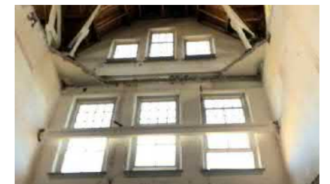
na verwijdering verlaagde plafond Tapijnkazerne
