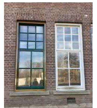
restauratie bestaande houten kozijnen Tapijnkazerne
