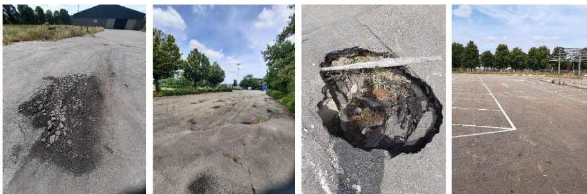
Figuur 4.1: Foto's met betrekking tot de kwaliteit van de aanwezige verharding
