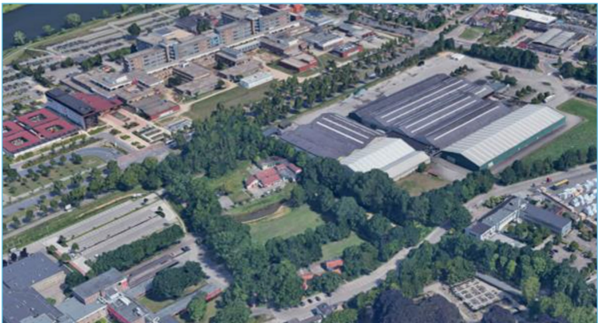
Figuur 1.1: luchtfoto huidige situatie
