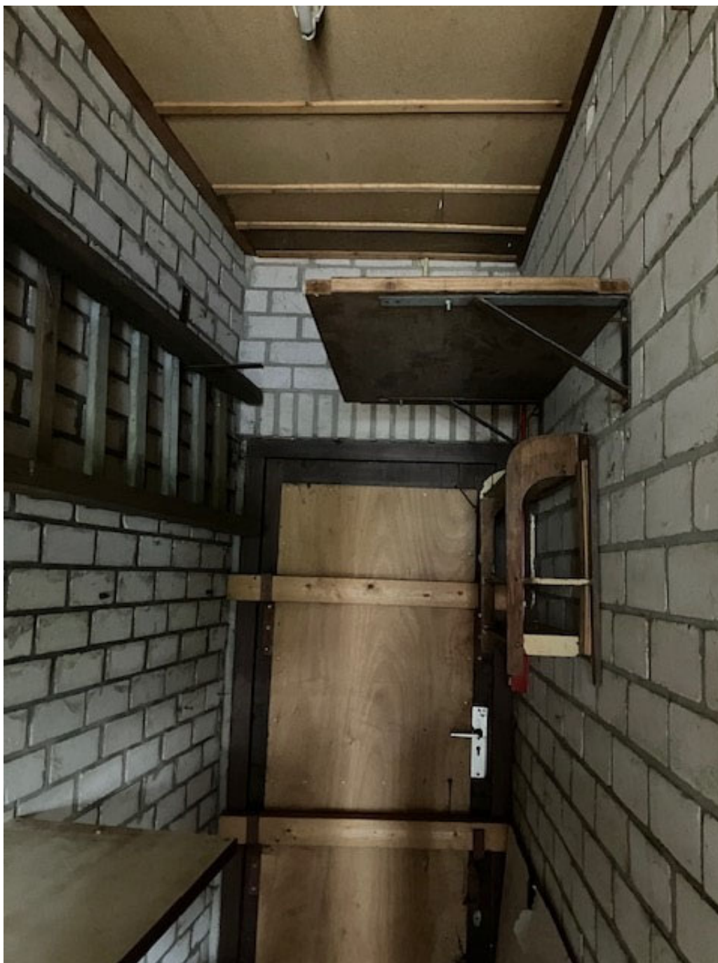
• Afbeelding 12: Binnenzijde te slopen garage
