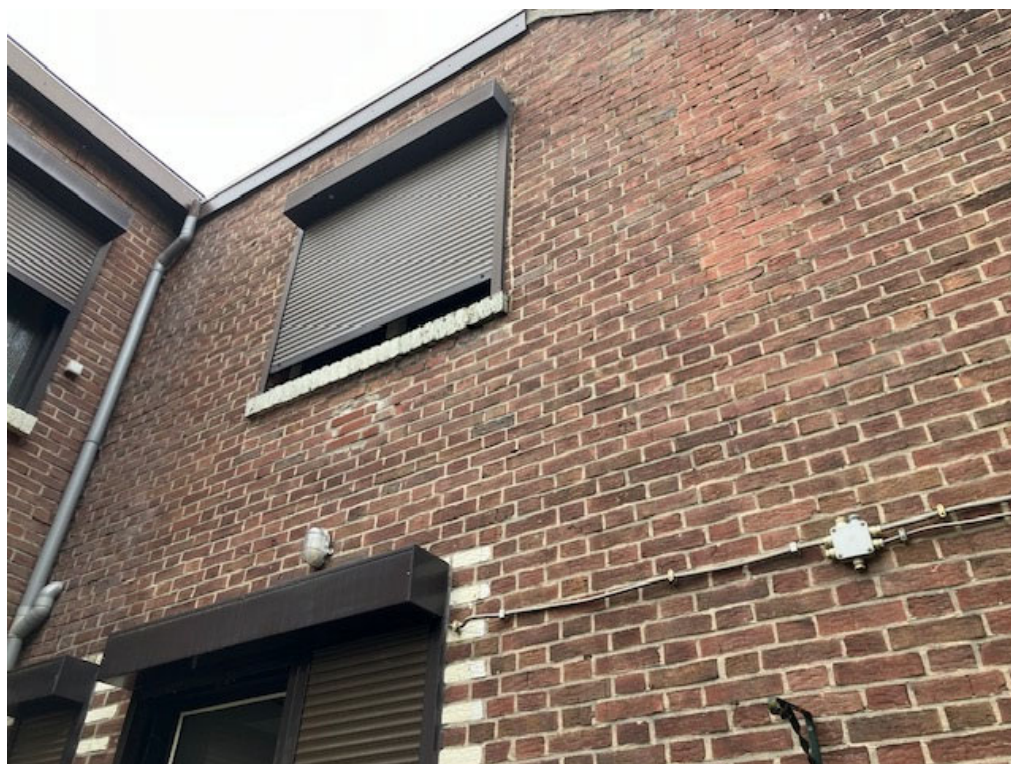
• Afbeelding 10: Linker zijgevel woning en voorgevel aanbouw, blijven behouden
