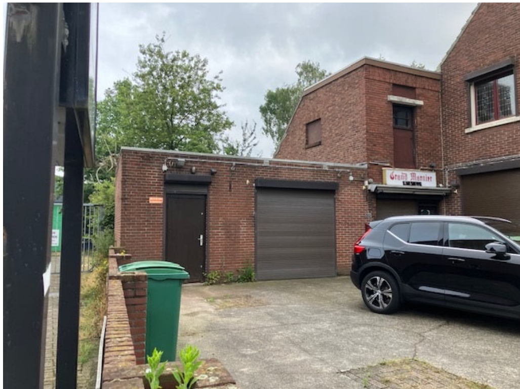
• Afbeelding 4: Te slopen garage, rechts de woning met aanbouw (blijven behouden)
