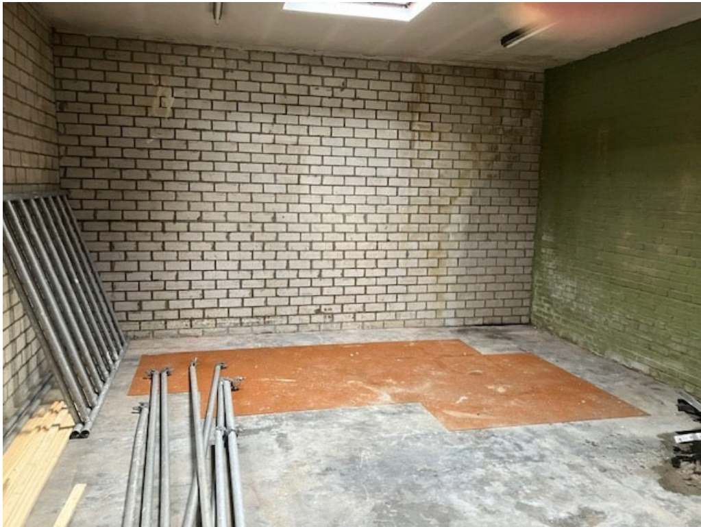
• Afbeelding 11: Binnenzijde te slopen garage
