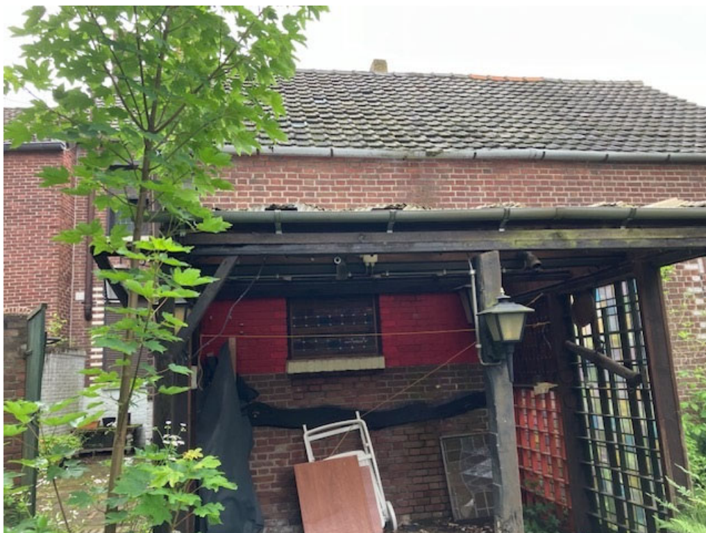
• Afbeelding 9: Overkapping aan achtergevel woning, blijft behouden
