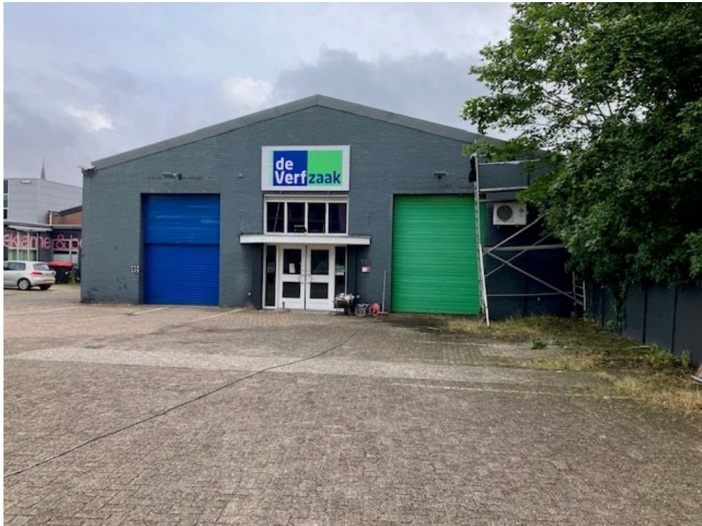
• Afbeelding 13: Voorgevel hal, geen bouwkundige veranderingen
