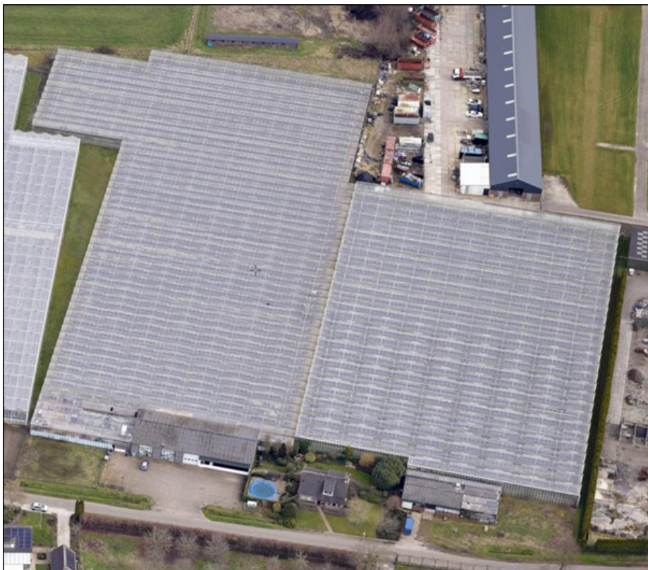
Foto bestaande situatie gezien vanuit de Vorstweg
