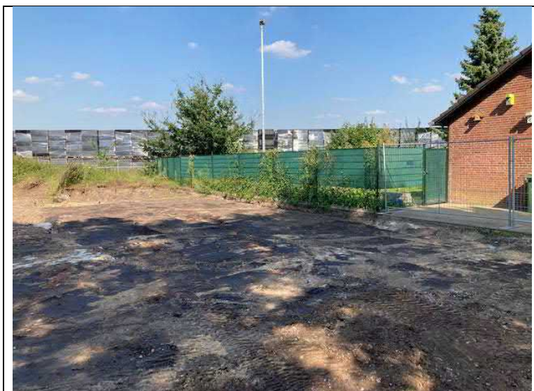
Foto 10: overzicht ontgraving bodem B7 en B6
