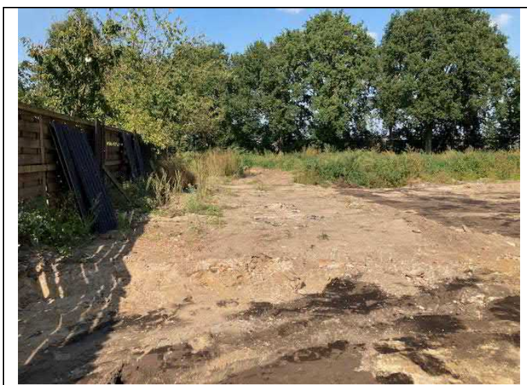
Foto 14: ontgraven van wand W5 gezien vanuit het zuiden
