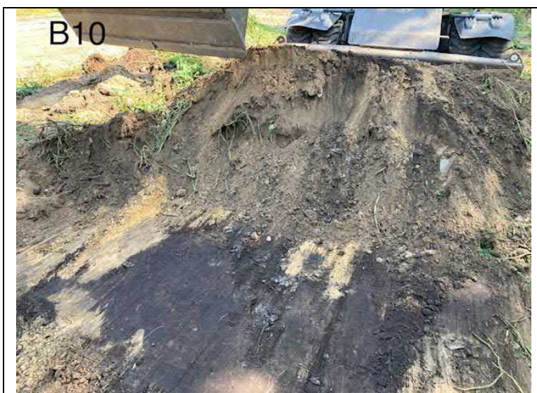
Foto 12: aanvullende ontgraving van bodem B10, vanwege het aantreffen van asbestmaterialen
