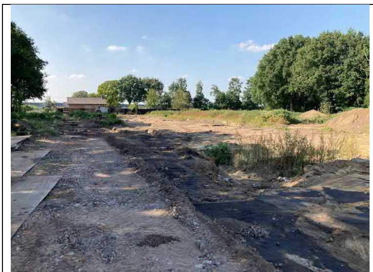
Foto 4: ontgraven van de bodem B3, B4 en B5 gezien vanuit het oosten
