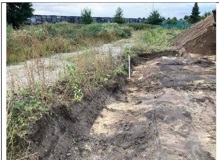
Foto 1: reeds ontgraven druppelzone aan de noordzijde van de (voormalige stal)
