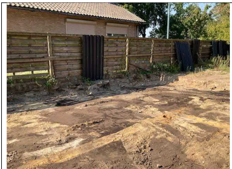
Foto 13: overzicht ontgraving bodem B9 gezien vanuit het zuidoosten
