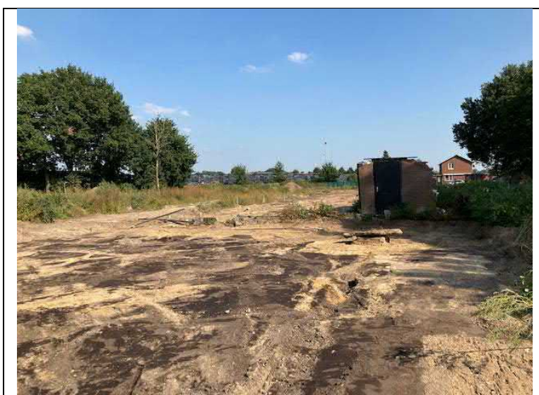
Foto 15: ontgraving bodem B8 gezien vanuit het westen
