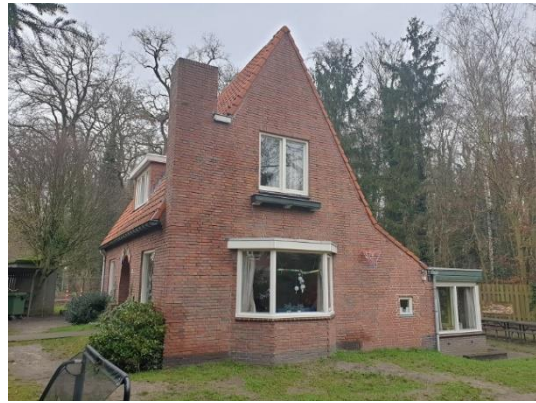
Figuur 5: De woning Leutherweg, gezien vanuit zuidelijke richting.
