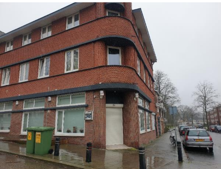
Aan de overzijde van het plangebied
