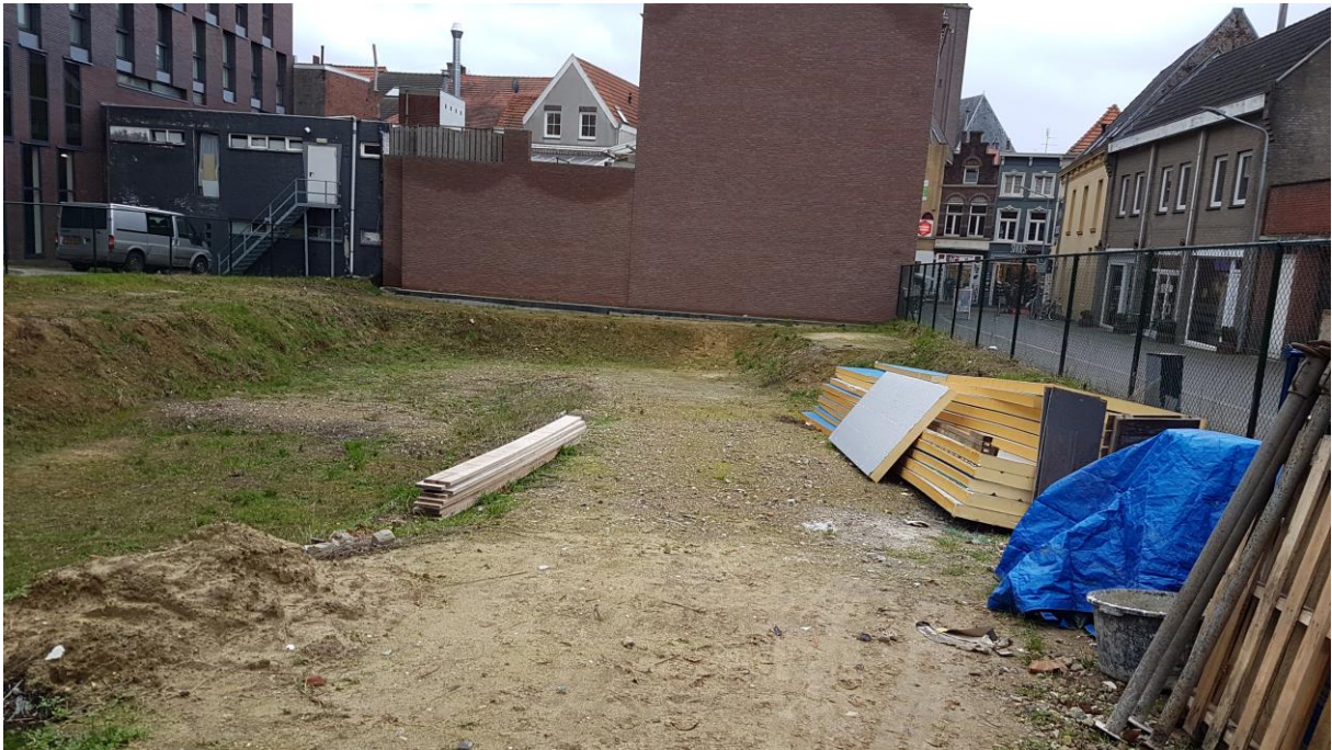
Foto 1: onderzoekslocatie Helschriksel waar al reeds een bouwput is gegraven in het verleden.
