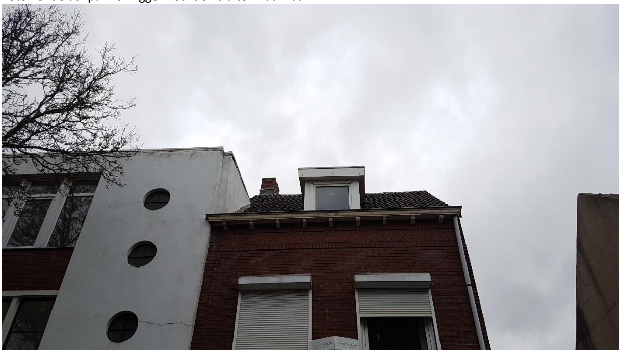
Foto 14: de dakpannen liggen recht en sluiten nauw aan.
