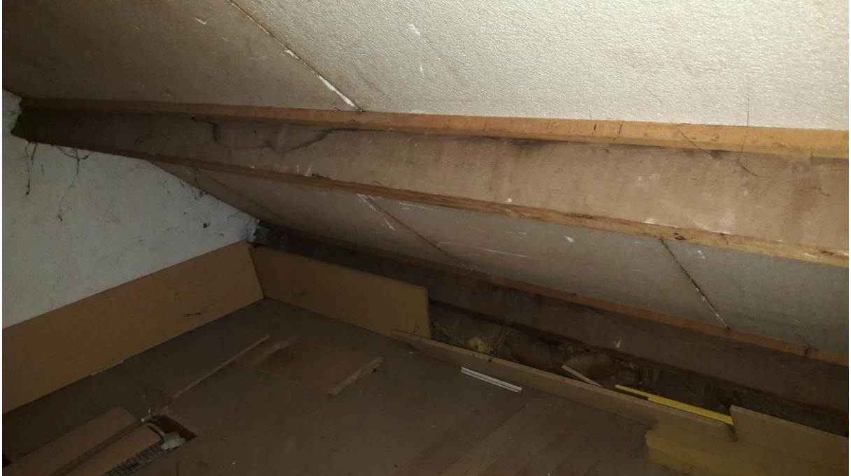
Foto 11: de afwerking op de zolder van de Ginkelstraat.
