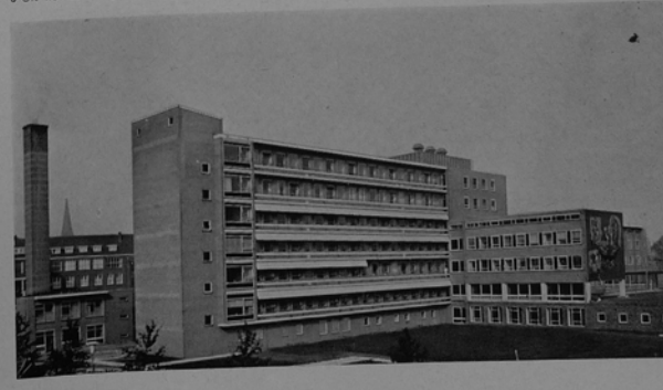
6 Uit het zuiden gezien
