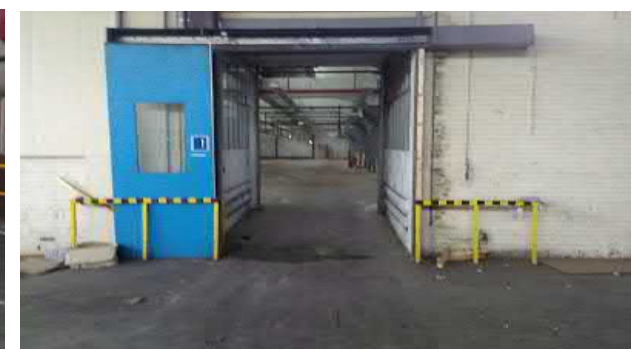
Foto 16. Toegang tussen hal 5 K en 5 C
