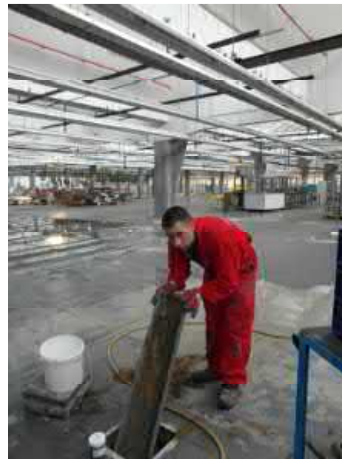
Foto 4: In 30cmx30cm gaten wordt de fundering en bodem onderzocht. Na beschrijving en monsternamen wordt de grond teruggelegd in de gaten.
