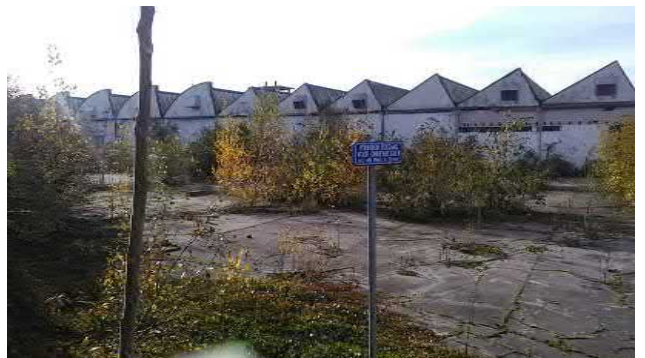
Foto 4. Complex 5 bij woningen Schutroestraat
