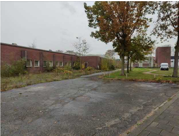
Foto 3: Asfaltweg op onderzoeklocatie met Complex 5 van voormalige Canon in de achtergrond.
