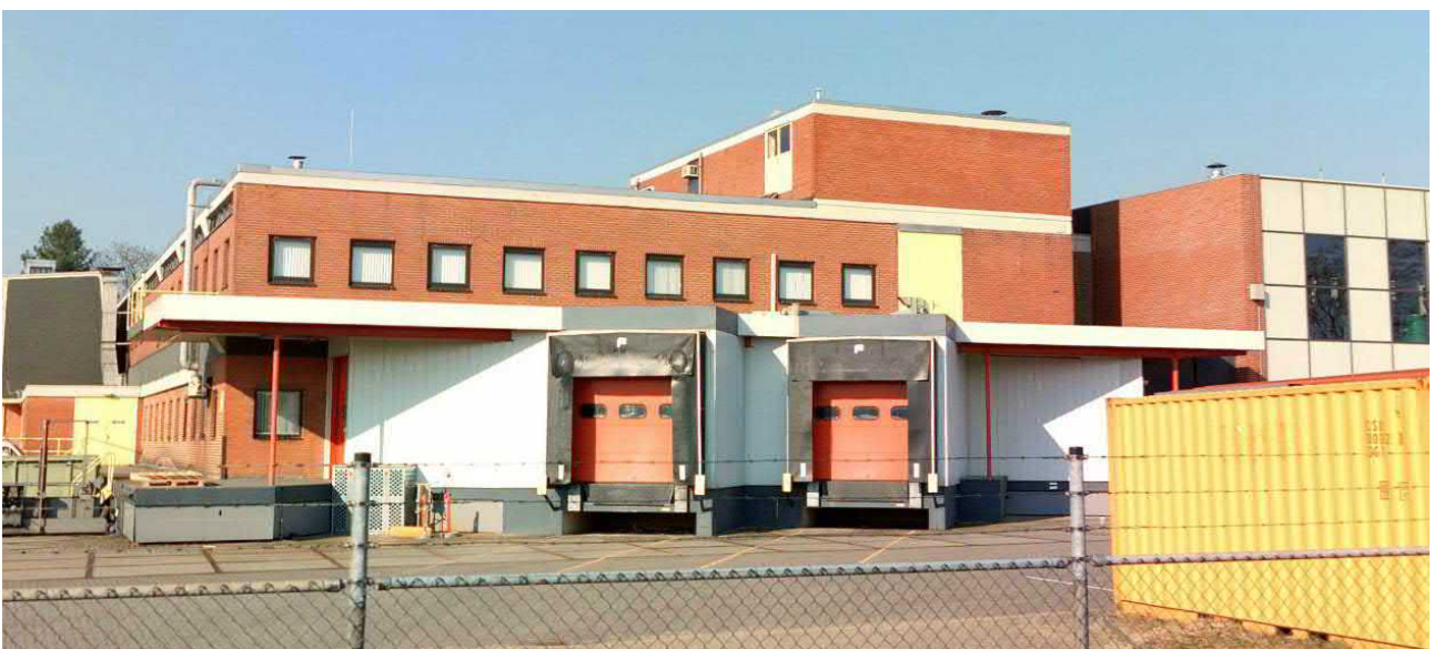
Figuur 3 gevels met rode en grijze bakstenen waar geen isolatie in de spouw aanwezig is en waar stootvoegen zijn uitgeboord om zo vleermuizen toegang te verschaffen als nieuwe verblijfplaats.
