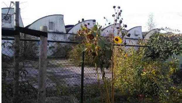
Foto 3. Complex 5 bij woningen Schutroestraat
