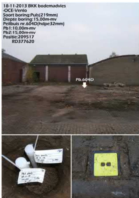
Foto 15: De diepe peilbuis 604D (15 m-mv) is geplaatst naast de gesloopte fietsenstalling bij Complex 6.
