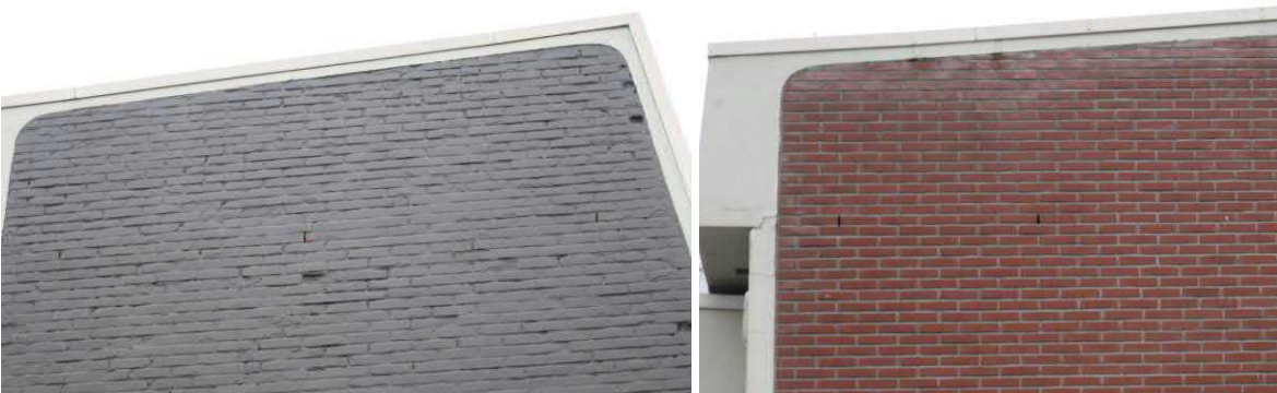
Nieuwe vleermuisopeningen in bestaande gevels.
