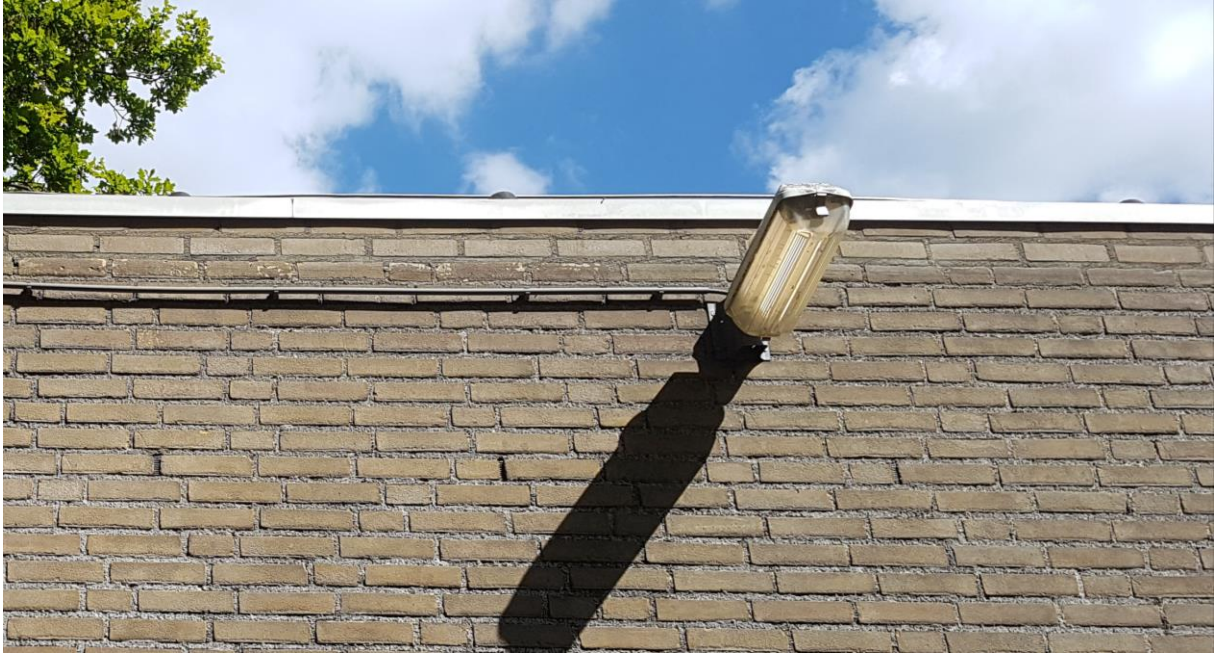
Foto 5: de openstootvoegen van de begane grond zijn afgewerkt met wespenbekjes.
