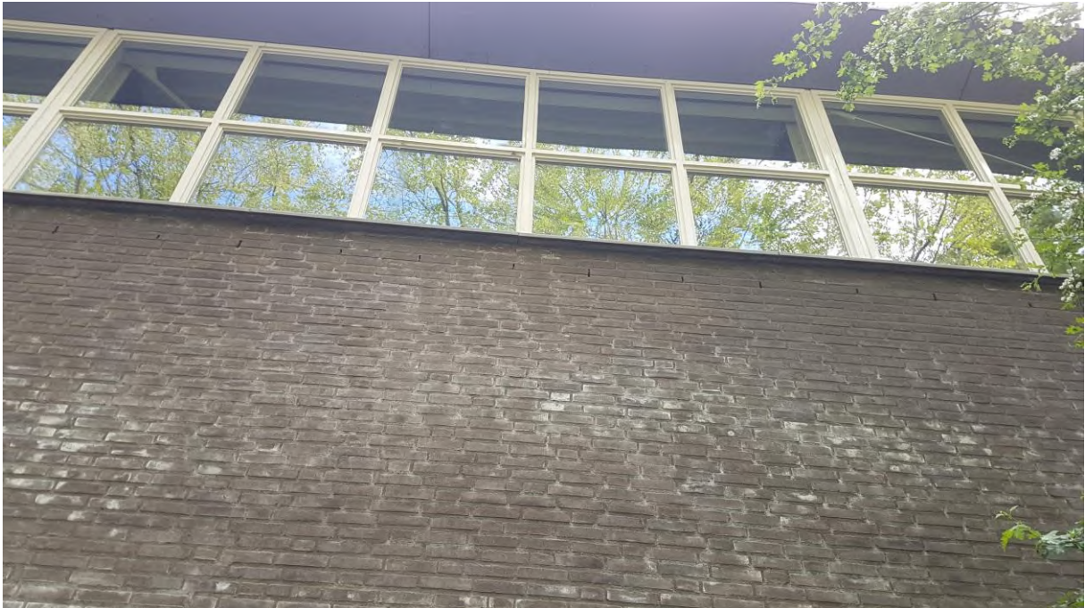
Foto 6: de openstootvoegen op de 1 ste verdieping zijn niet afgewerkt met wespenbekjes waardoor dit een verblijfplaats biedt voor vlermuizen.
