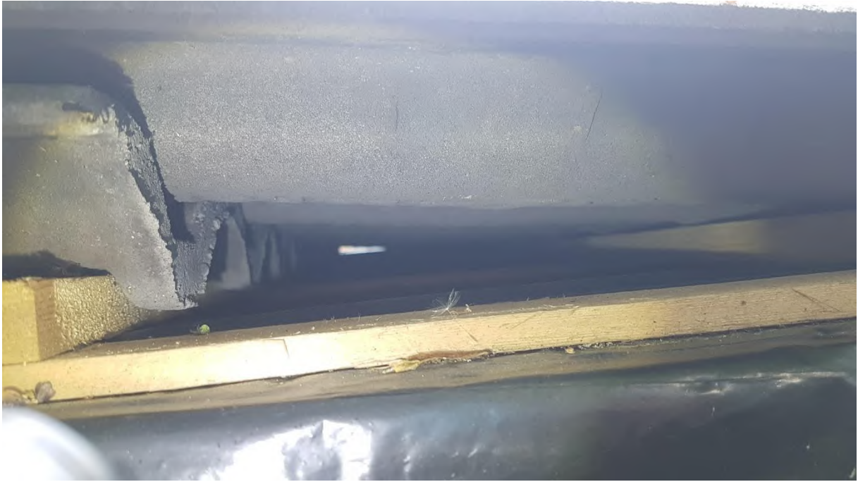
Foto 29: controle onder de dakpannen van het schuurtje.
