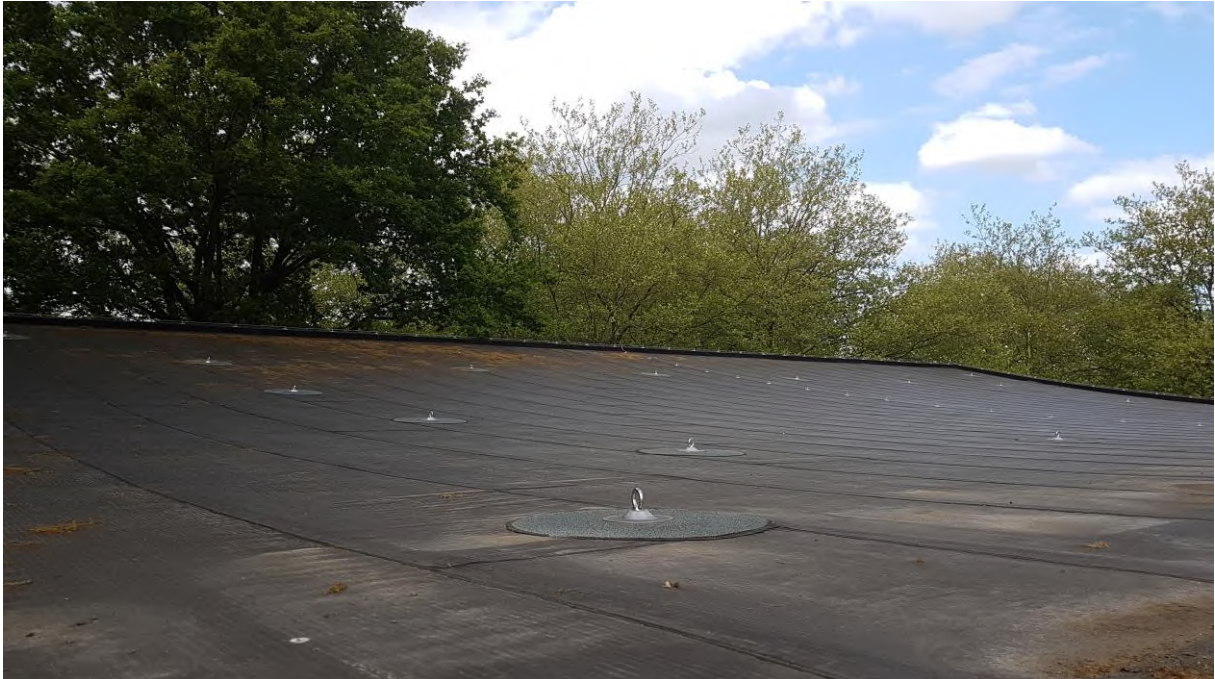
Foto 8: het "platte" dak van het te slopen zwembad. Er zijn geen sporen van (oude) nesten.
