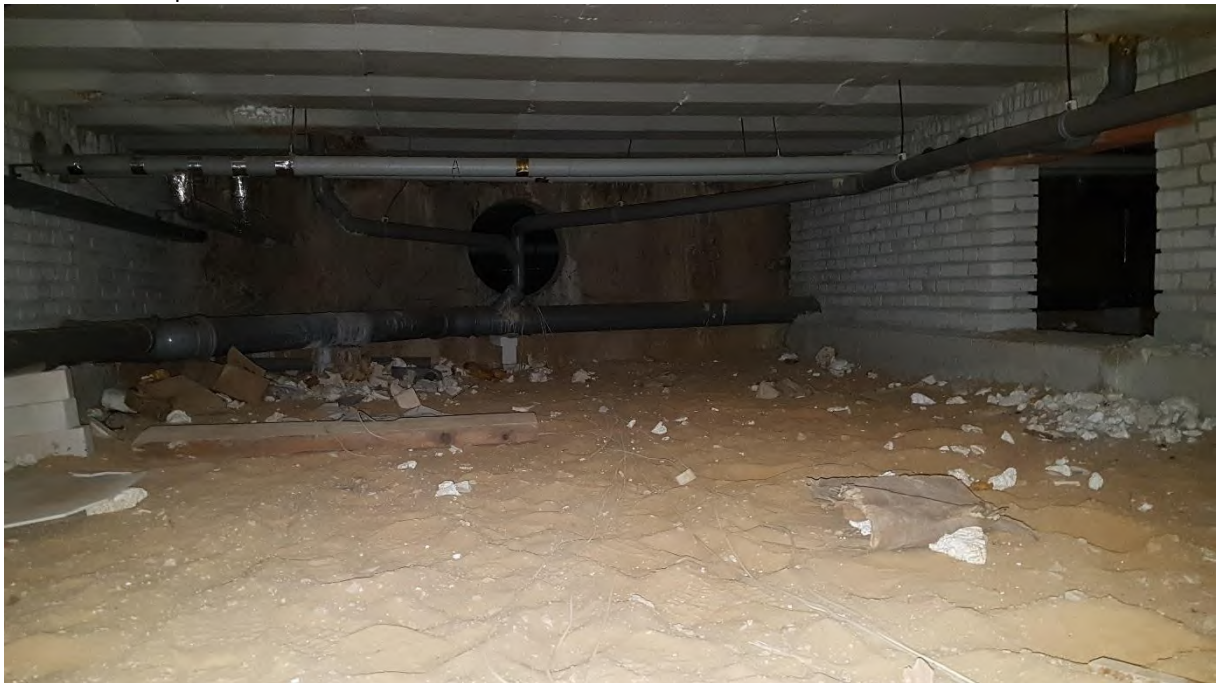
Foto 14: een deel van de kruipruimte onder het zwembad.
