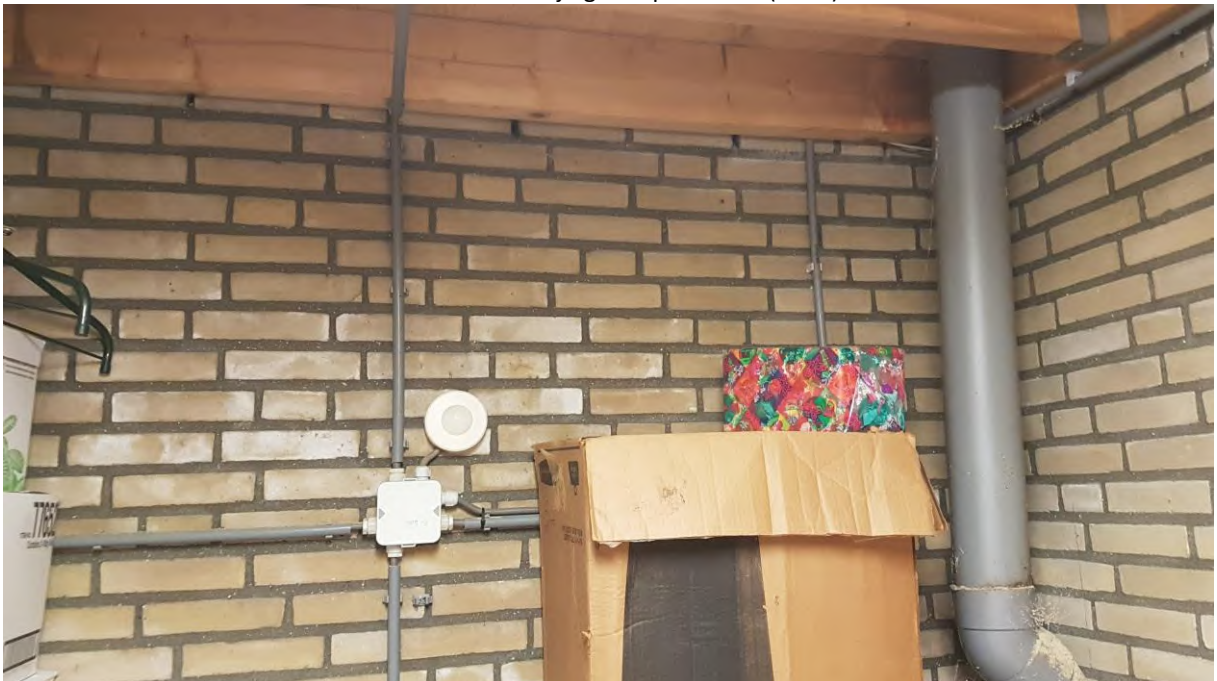
Foto 12: de vliering in het te slopen binnenbad. Er zijn geen sporen aangetroffen van dieren.
