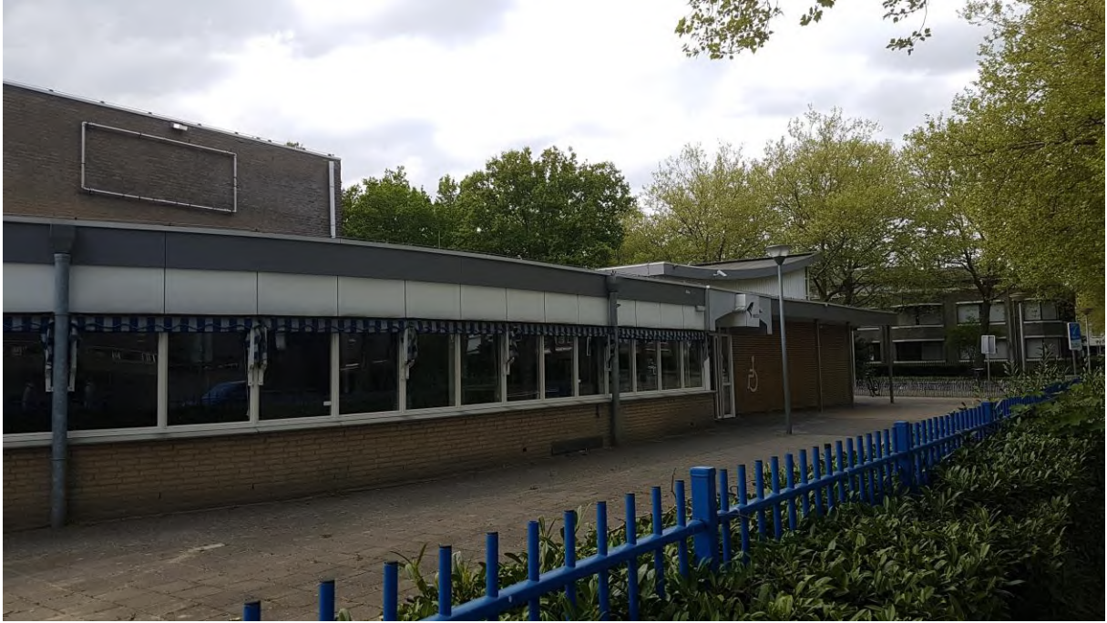
Foto 1: het noordelijke deel van de onderzoekslocatie, hier in de voorgrond het binnenbad de Wisselag. De gevel is afgewerkt met boeiboorden die nauw aansluiten.
