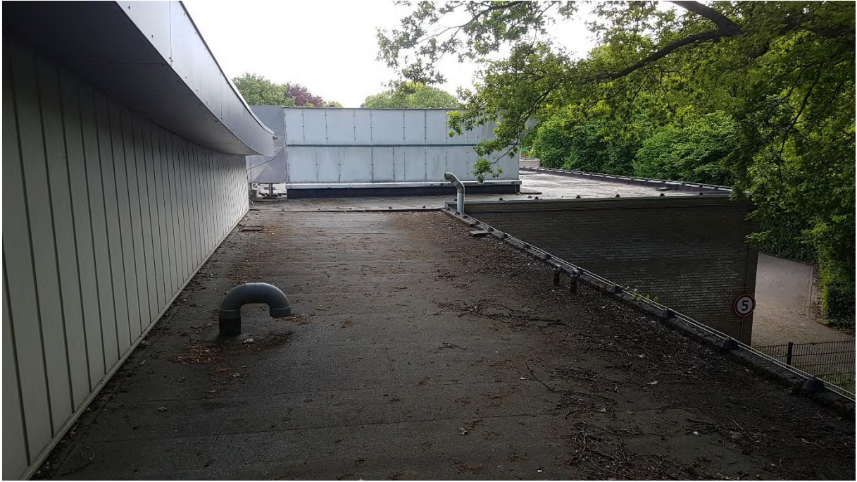
Foto 9: de daken vanaf de noordzijde. N.B. is de foto gemaakt boven de vliering. Er zijn geen sporen van (oude) nesten.
