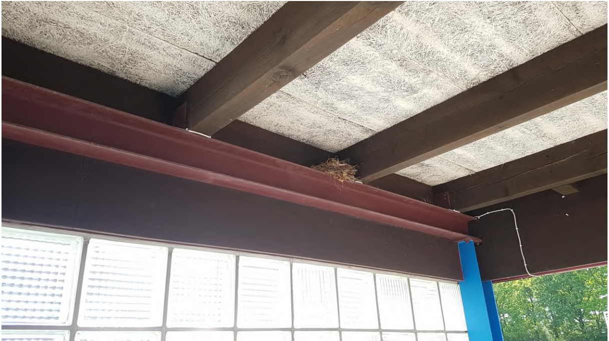
Foto 20: het dak van de kleedruimtes met een van de aangetroffen nesten.
