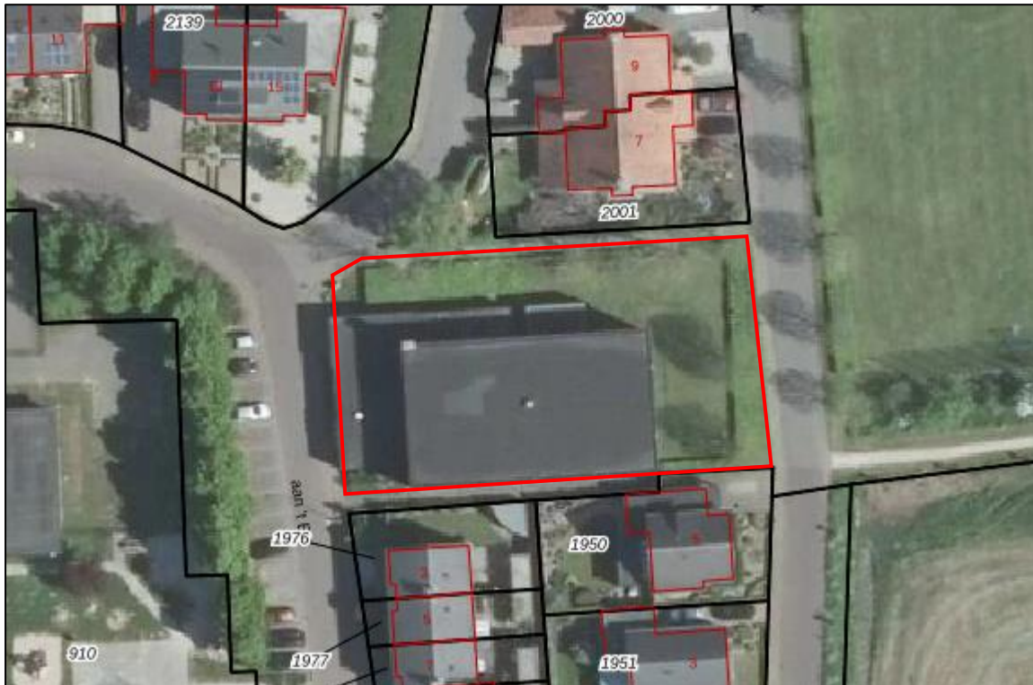
Figuur 5: Luchtfoto uit 2016 van de in 2017 gesloopte bebouwing binnen het plangebied, aangegeven met het rode kader (Bron: www.pdok.nl/viewer ).
