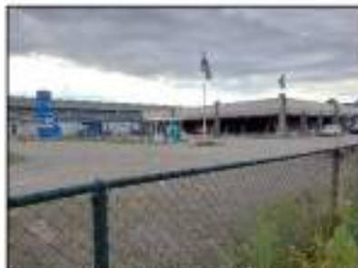
Figuur 3. Overzicht planlocatie, kijkrichting zuidelijk.
