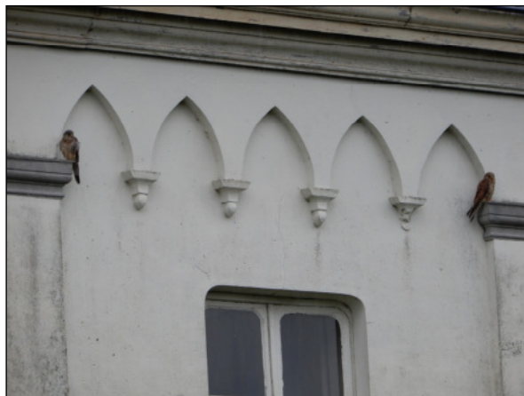
Foto 8: twee torenvalken, aanwezig op de noordgevel aan de westkant van het gebouw
