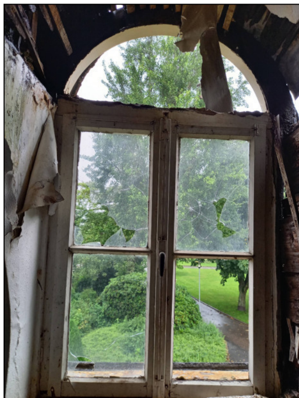
Foto 10: opening boven en rechts onder
