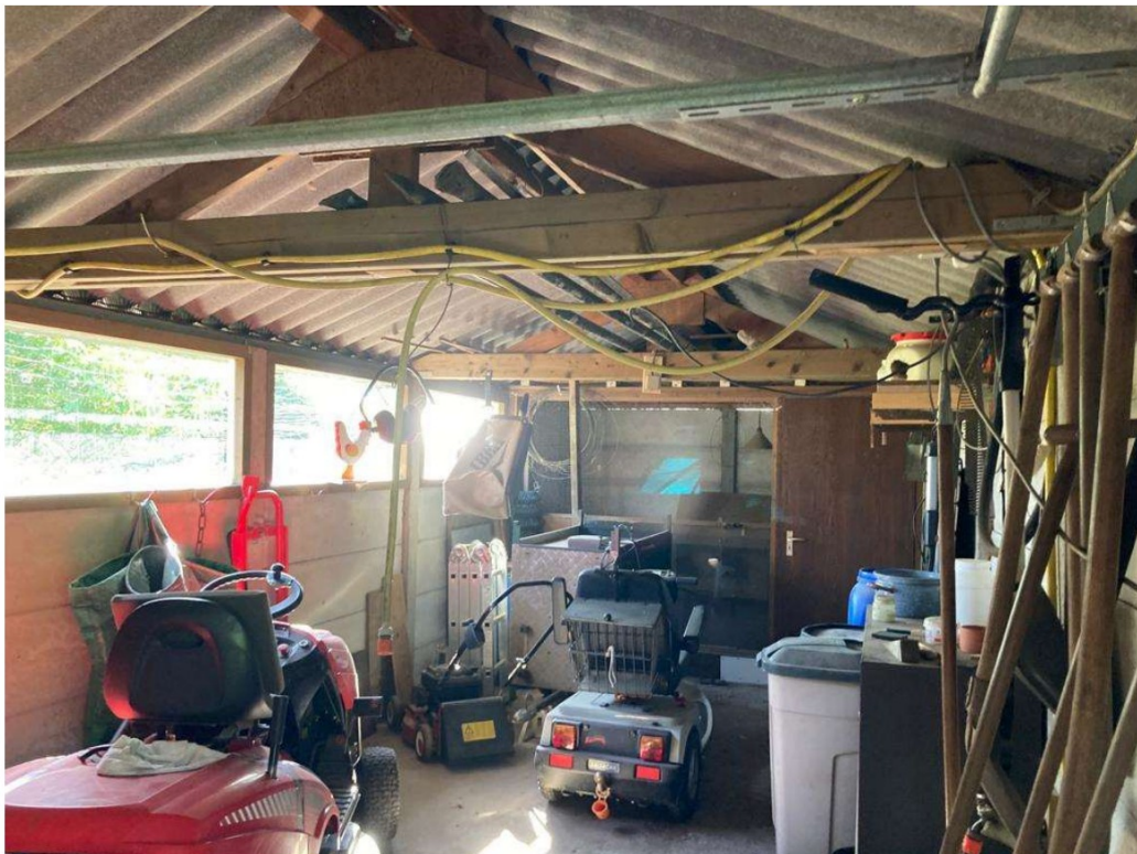
• Afbeelding 13: binnenzijde te slopen bijgebouw, voorzien van ongeïsoleerde golfplaten
