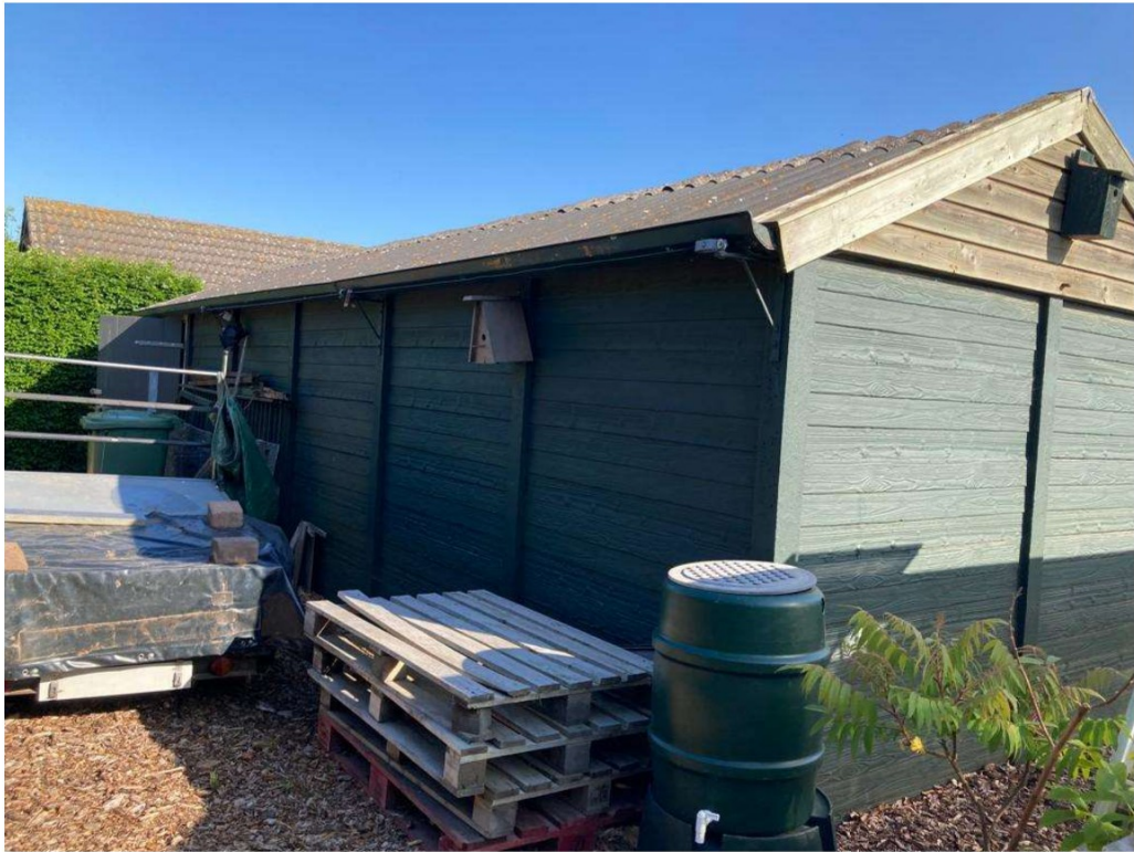
• Afbeelding 8: te slopen bijgebouw
