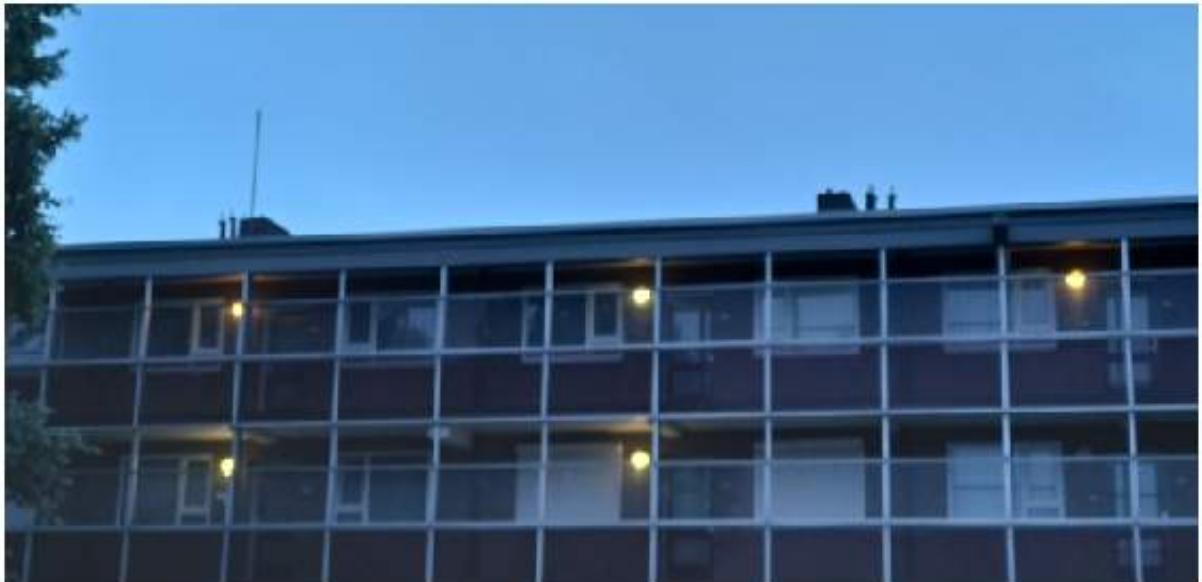
Foto's 4a,b: locatie E (achtergevel van de zuidvleugel van het complex), de vleermuisverblijfplaats bevindt zich mogelijk in de schoorsteen, die achter de boom, links op de foto, verscholen is, nabij de zijgevel (locatie F)
