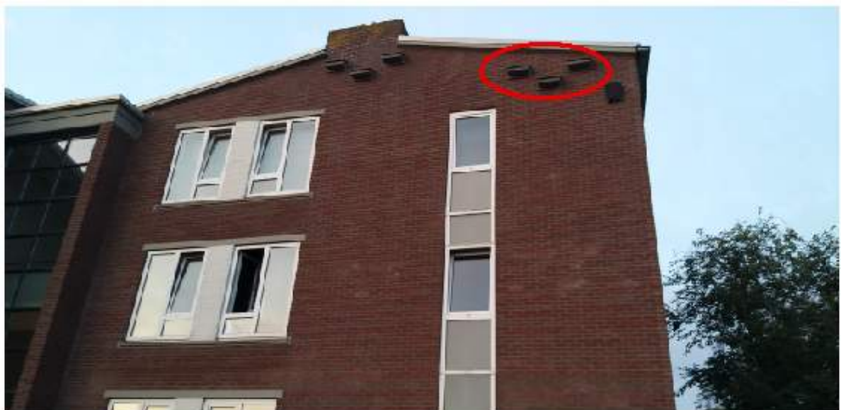
Foto 1: Gevel met kasten (rood omcirkeld) door huismussen gebruikt
