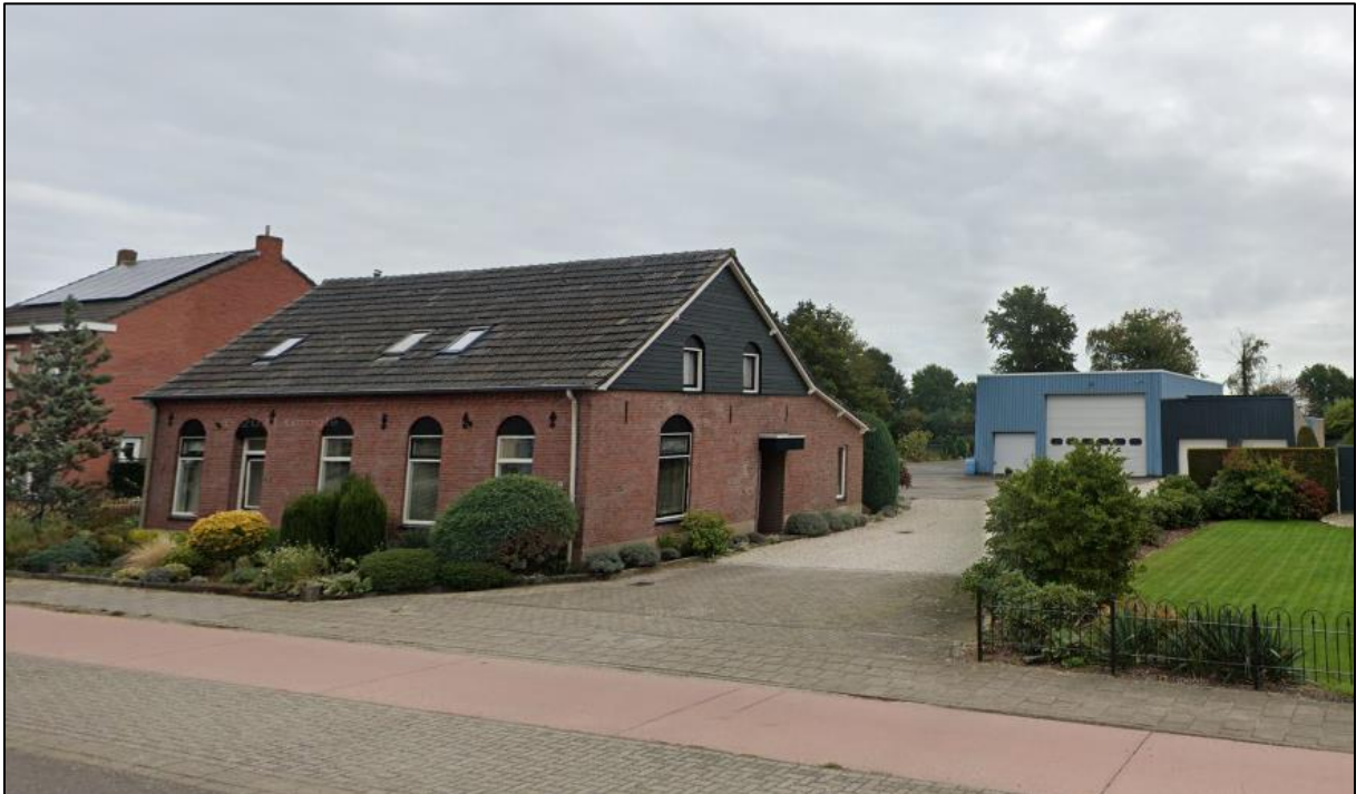
Afbeelding 3. De twee-onder-een-kapwoning Rijksweg 73-75 met rechts daarachter de voormalige bedrijfsruimte
