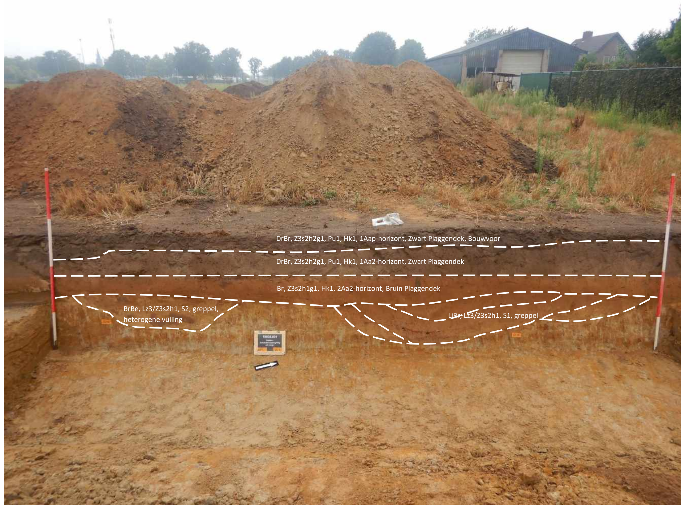
Afbeelding 21. Spoor 1 en 2 Vlak 1 Werkput 1
