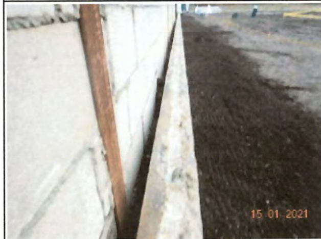
Foto 11: Verwijderde bron M1 en maaiveld.
