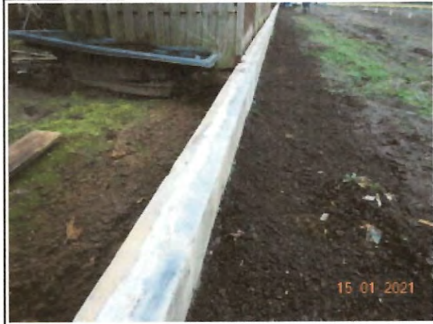
Foto 10: Verwijderde bron M1 en maaiveld.
