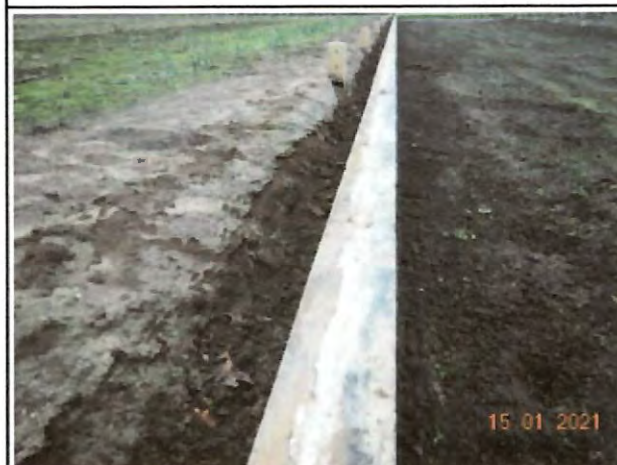
Foto 6: Verwijderde bron M1 en maaiveld.
