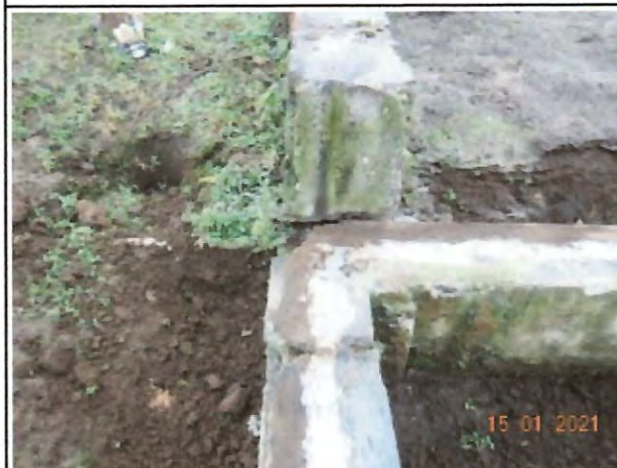
Foto 5: Verwijderde bron M1 en maaiveld.
