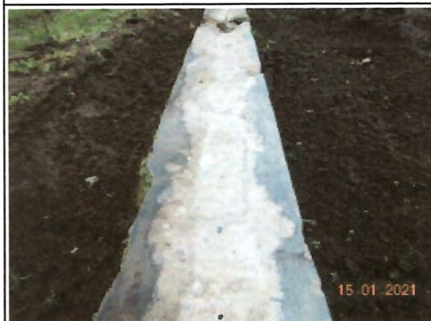
Foto 9: Verwijderde bron M1 en maaiveld.
