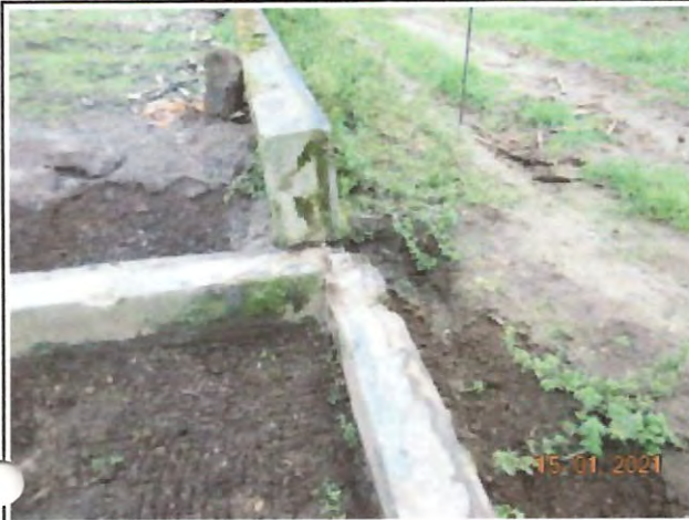
Foto 7: Verwijderde bron M1 en maaiveld.
