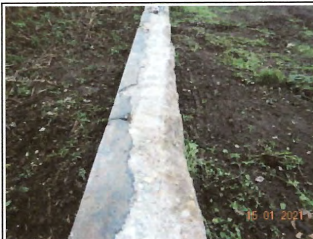
Foto 4: Verwijderde bron M1 en maaiveld.
