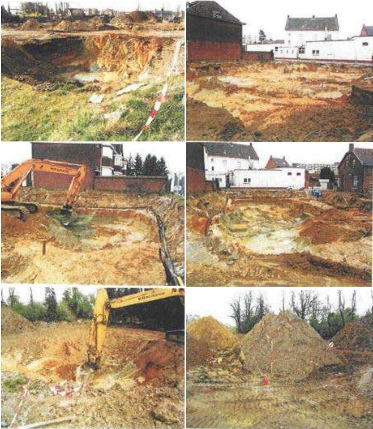
Figuur 16: Fotomateriaal van de bodemsaneringswerkzaamheden 2005.
