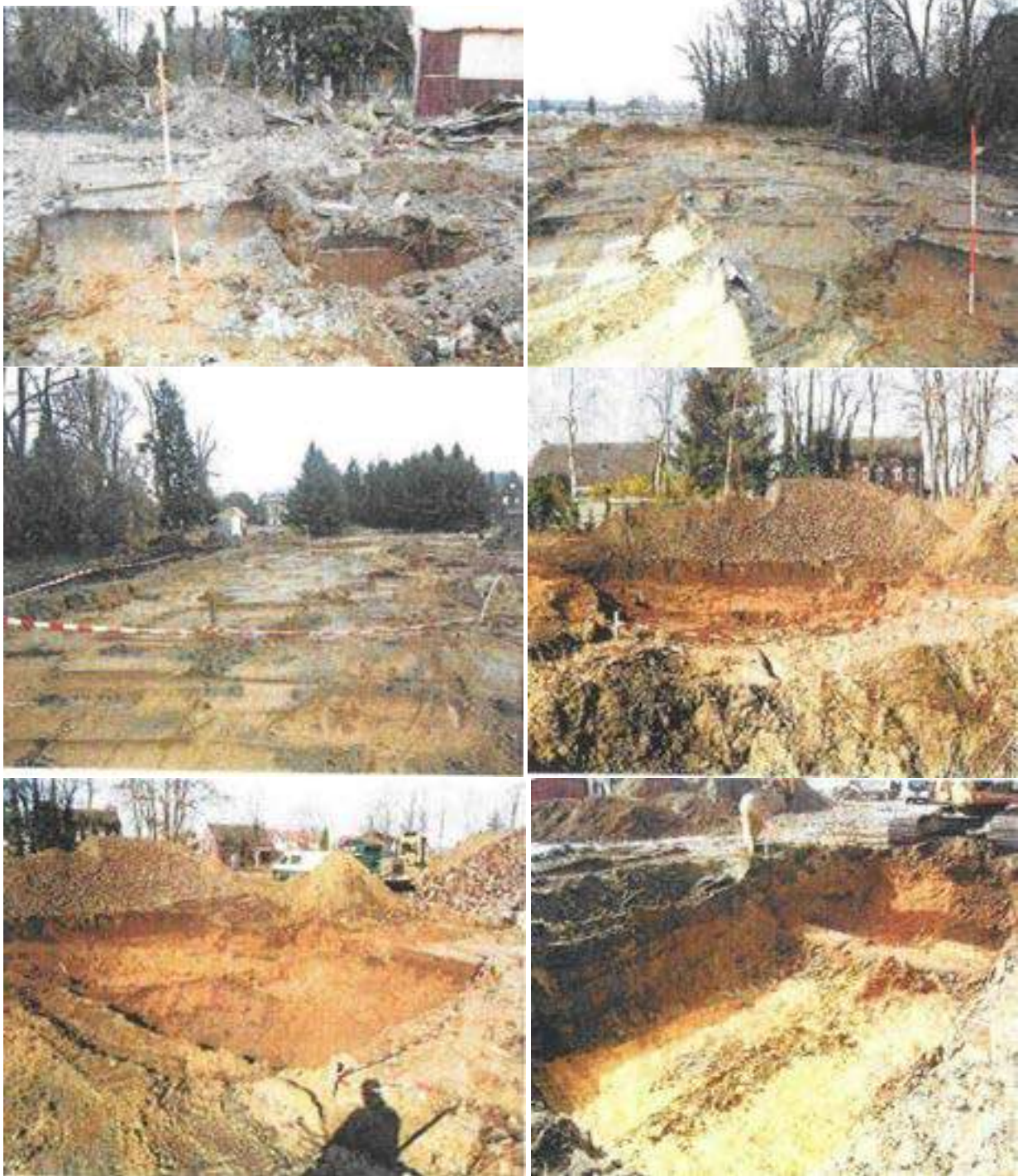
Figuur 15: Fotomateriaal van de bodemsaneringswerkzaamheden 2005.
