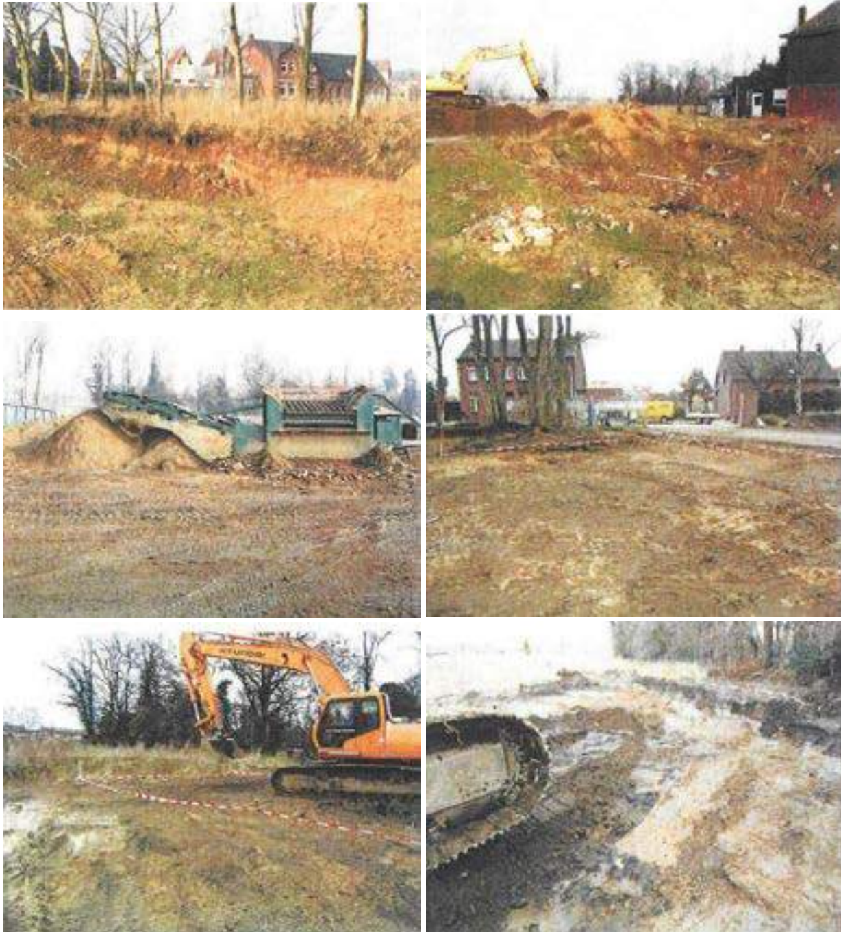
Figuur 14: Fotomateriaal van de bodemsaneringswerkzaamheden 2005.
