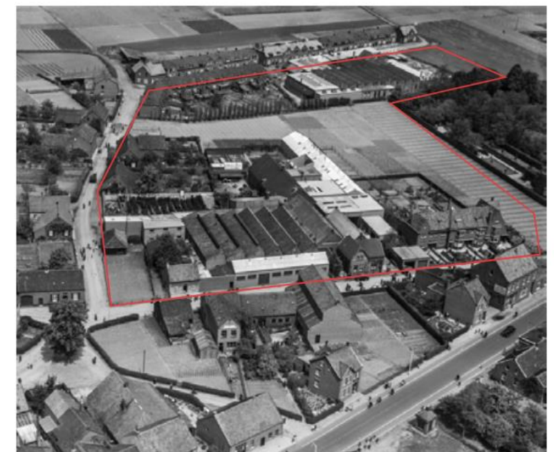
Luchtfoto 1923 de typerende dakvorm en baksteen komt terug in nieuwe de planvorming
