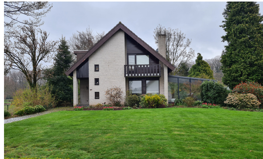
Figuur 8: De bestaande woning aan de Koelderstraat 86.
