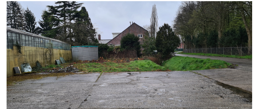
Figuur 10: De kassen met stenig aanzicht aan de zuidzijde van de bestaande woning.
